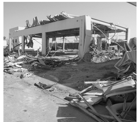
壊滅状態の県南浄化センター
