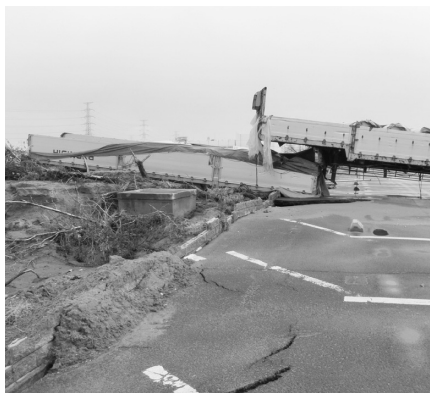
仙台港 写真左側では液状化現象も見られる
